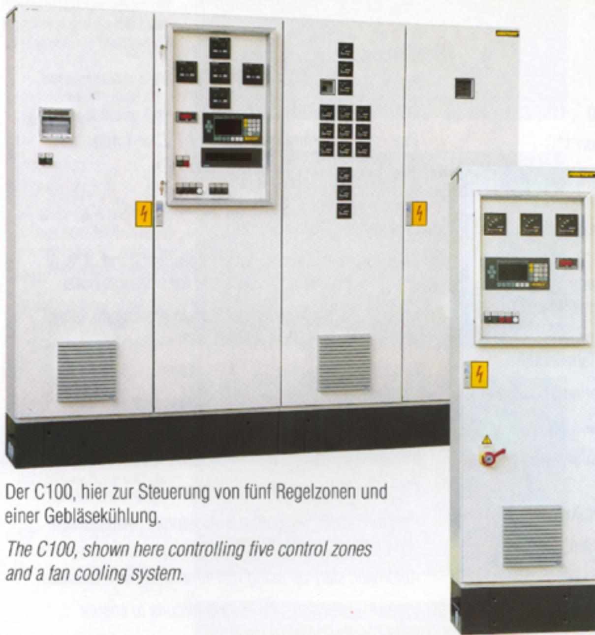
Der C100, hier zur Steuerung von fünf Regelzonen und einer Gebläsekühlung.
